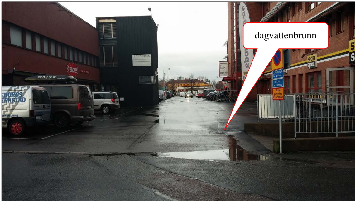
Figur 4. Vy mot norr. Markytan är asfalterad.
