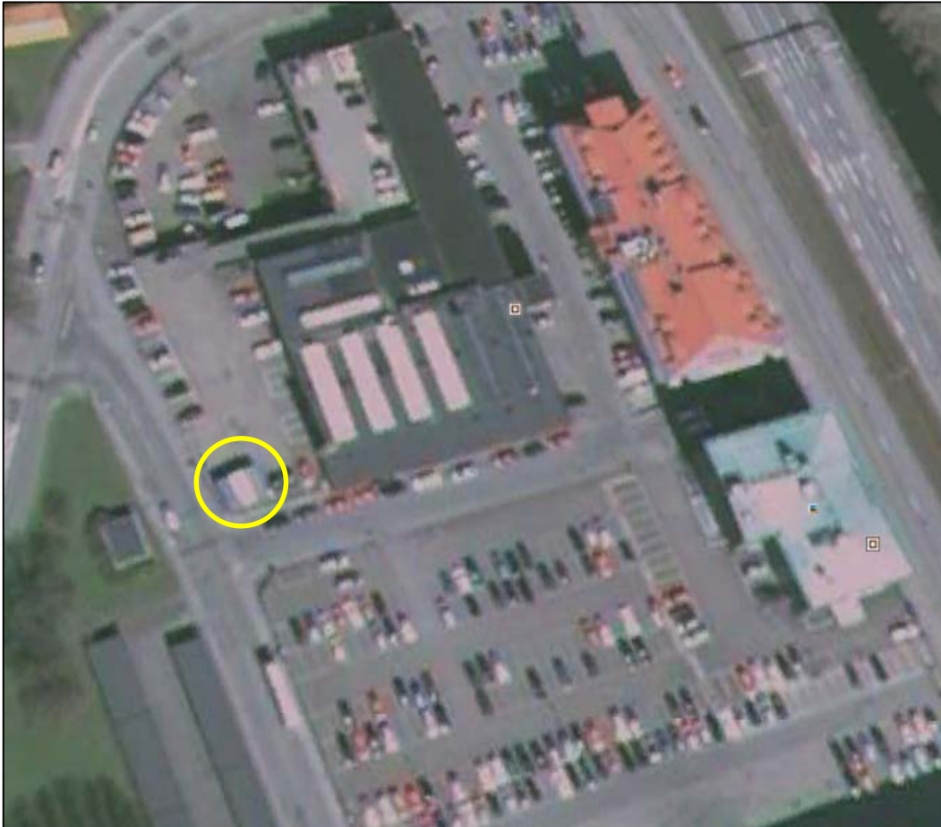
Figur 6. Flygbild från Google Maps, 2005. Gul ring visar det plåtskjul som revs ca 2006.
